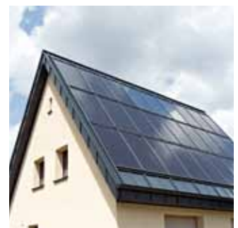
Exemple de toiture Sunroof complète associant thermique et photovoltaïque
